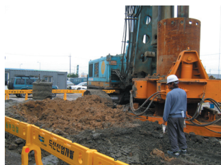
> 콘크리트 타설 완료 및 되메우기
