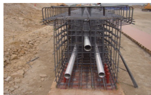
2. 철근조립 및 슈스관 설치
