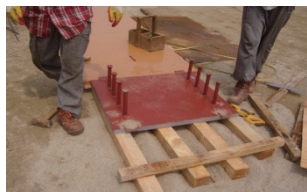
1. 제작대 및 Sole Plate 설치
